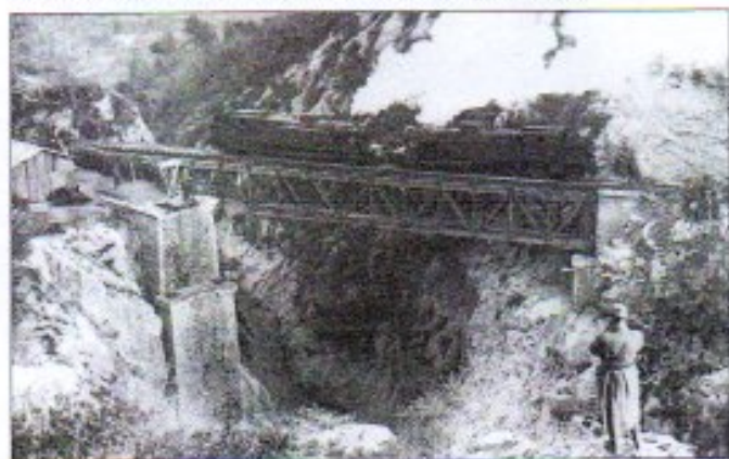
Essais avec deux locomotives sur le pont provisoire
