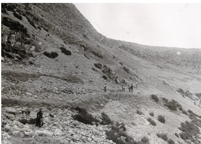
Ascros, bassin du ravin du Moulin de Fraissinet. Crête de Rorebel. Calcaires dolomitique de l'infrales. Exposition Nord. Exécution de la plantation en 1908 en pins noirs et sylvestres des parcelles A 394 et 392. Fonds RTM.
