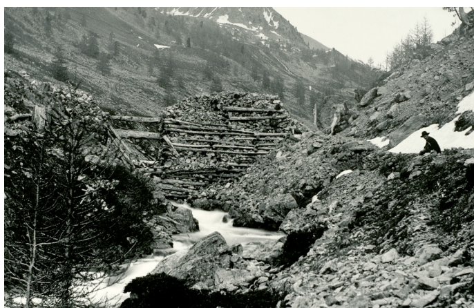
Barrage pour le flottage du bois, Vallon de Chastillon, Tinée, 23 mai 1899. Cliché Victor de Cessole. Coll. Bibliothèque de Cessole, Ville de Nice.
