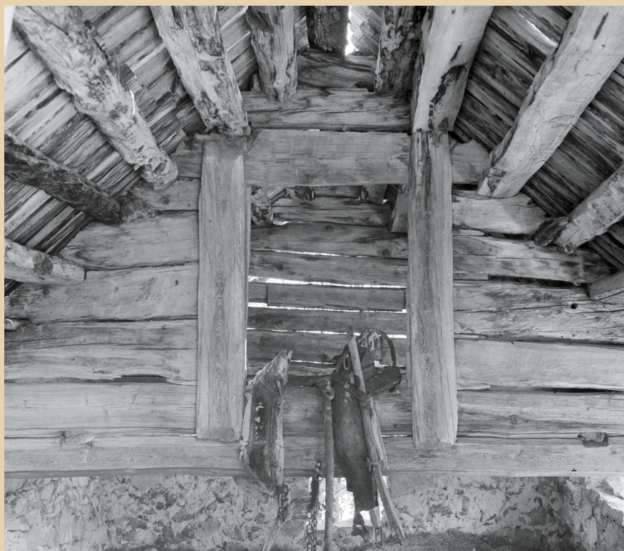
Sousta (abri) à la toiture en mélèze, hameau de Barel, 2001. Coll. Roudoule.
