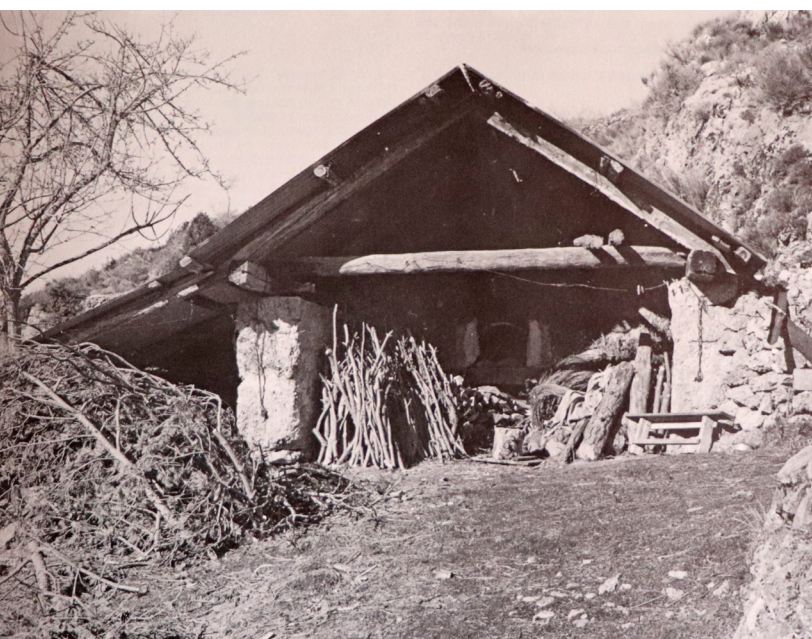
Bois de chauffage. Péone, Saint-Brès, 1982. Paul Raybaut.
