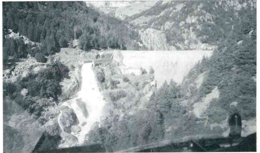
Le barrage des Mesces, vu d'hélicoptère. On distingue à gauche le volume d'eau impressionnant qui s'échappe par l'évacuateur de crue. Photo EDF - GEH Var-Roya
