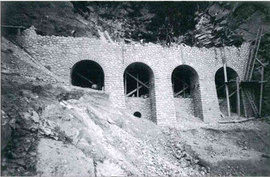
Un groupe d'ouvriers sur le chantier de la ligne Nice - Coni. Ci-dessous, la construction en juin 1923 de la galerie paravalanches reliant les deux tunnels de St.Roch, en contrebas du village de Saorge. Ce lot a été réalisé par l'entrepreneur François Mercier puis, à la mort de celui-ci en 1920, par son successeur André Borie. Collection Michel BRAUN
