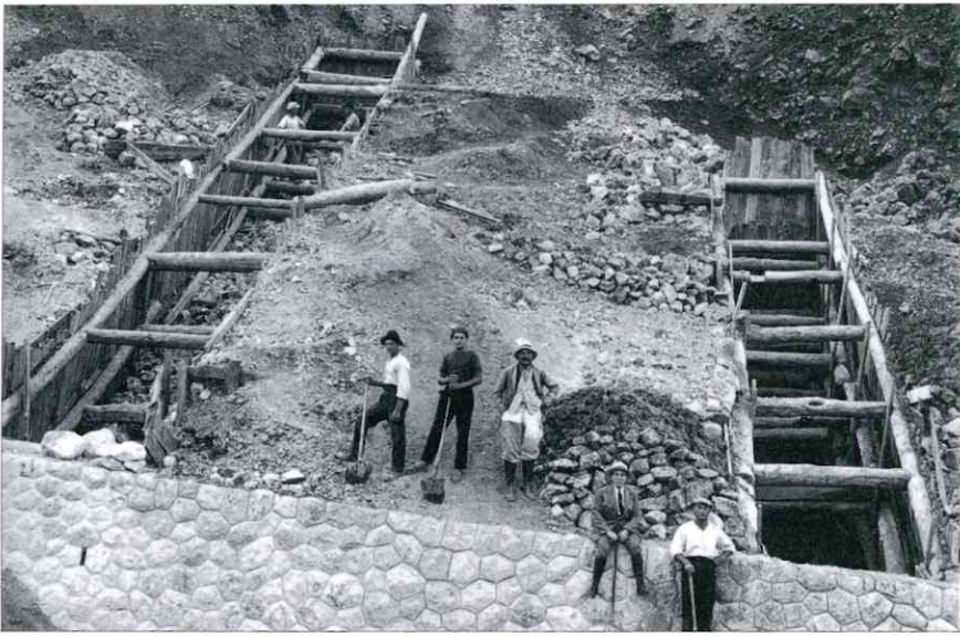
Un groupe d'ouvriers sur le chantier de la ligne Nice - Coni. Ci-dessous, la construction en juin 1923 de la galerie paravalanches reliant les deux tunnels de St.Roch, en contrebas du village de Saorge. Ce lot a été réalisé par l'entrepreneur François Mercier puis, à la mort de celui-ci en 1920, par son successeur André Borie. Collection Michel BRAUN
