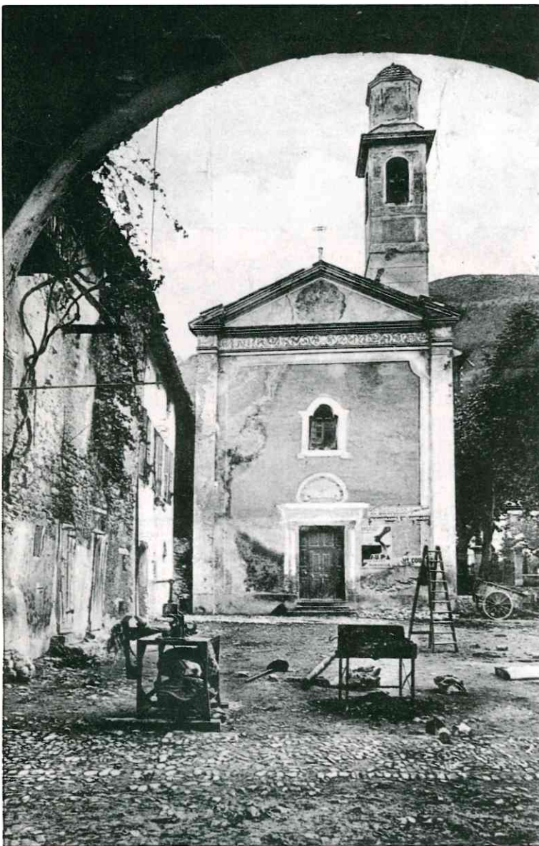
Cette carte d'un coin de la place Saint-François évoque un souvenir de notre enfance. Pour les besoins d'un chantier, les ouvriers ont déployé un établi avec une forge à charbon, généralement équipée d'un ventilateur manuel pour aviver la braise. Collection Jean-Pierre GARACIO
