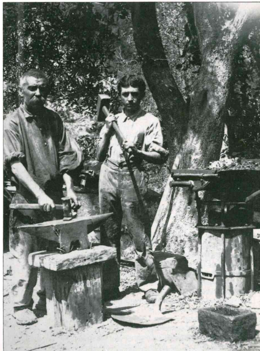
Cette carte d'un coin de la place Saint-François évoque un souvenir de notre enfance. Pour les besoins d'un chantier, les ouvriers ont déployé un établi avec une forge à charbon, généralement équipée d'un ventilateur manuel pour aviver la braise. Collection Jean-Pierre GARACIO
