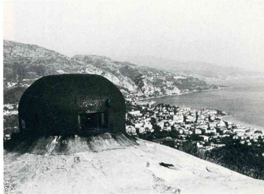
La ligne Maginot, célèbre par ses fortifications du Nord-Est, s'étendait pourtant jusqu'aux rivages méditerranéens. Ci-dessus, le fort de Roquebrune et Menton, en Décembre 1983. Photo Yann DUVIVIER
