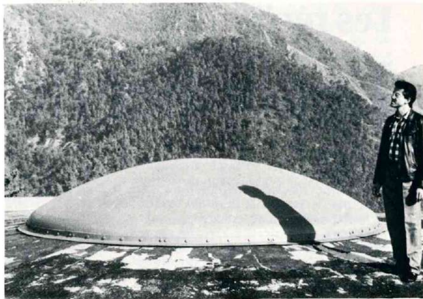
La tourelle de canons de 75 mm du fort de l'Agaisen - bloc 3, en position repos. Photo Yann DUVIVIER
