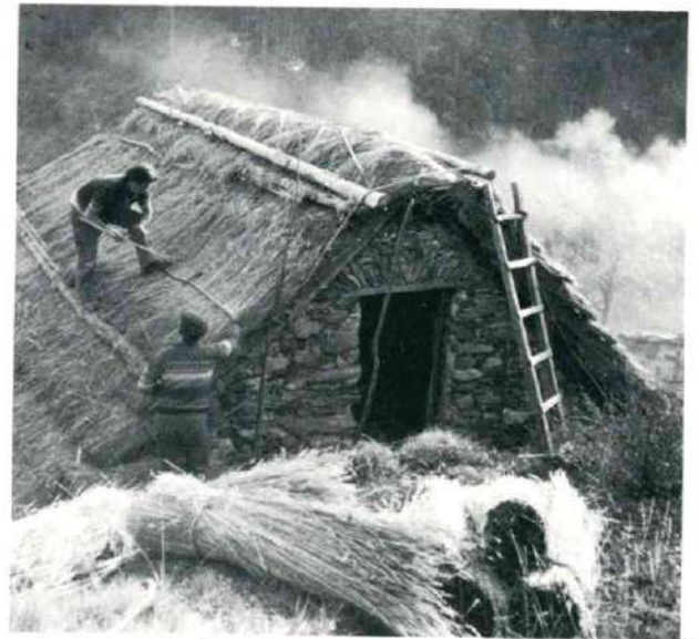
Mise en place des perches qui fixent le seigle à la charpente.
