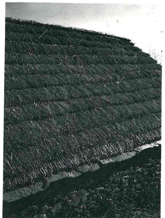
Le tout est terminé. C'est tellement plus beau et plus efficace que la tôle !
