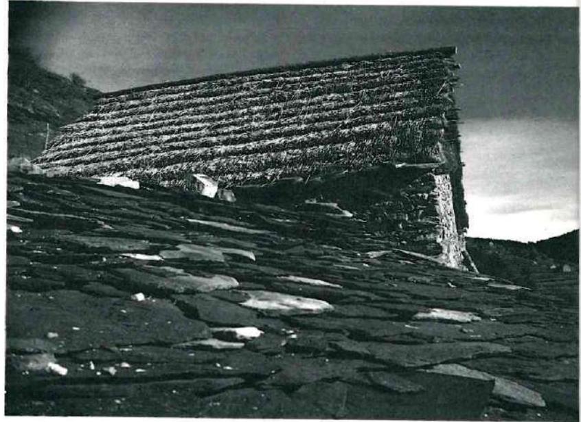
Contraste entre la lauze et le chaume, deux matériaux de couverture traditionnels de la vallée de la Roya...
