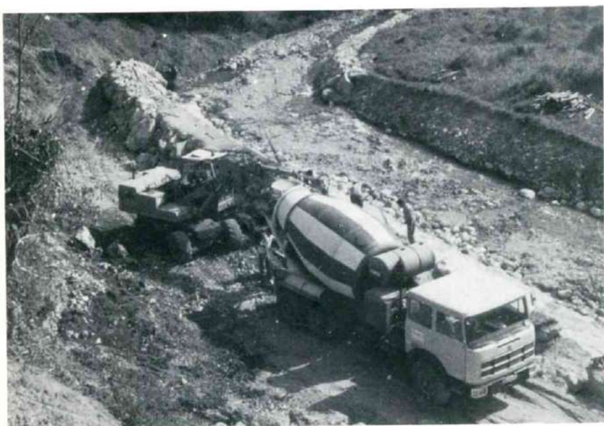
Déjà vers 1909, la route Menton – Sospel a subi un premier élargissement sur son versant méridional (ci-dessus), pour livrer passage à la voie du tramway. Aujourd'hui, c'est cette plateforme ferroviaire qui est élargie à son tour sur le versant nord (ci-dessous, la construction d'un mur de protection contre le torrent du Merlanson). L'ancien tunnel du tramway sous le col de Castillon sera aménagé et constituera l'élément majeur de la nouvelle «pénétrante» routière (ci-dessous à droite). Collection Ch. MARTINI-DE-CHATEAUNEUF & photo J-P. DOMÉREGO
