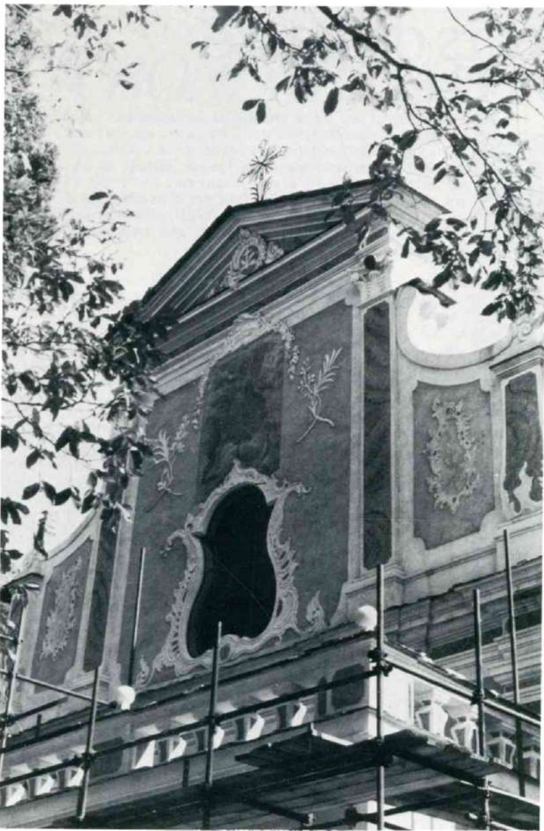
Le fronton restauré sur la façade principale du couvent de Saorge. Photo Hervé ROMAN
